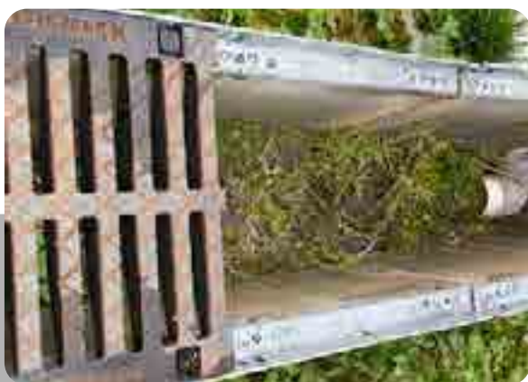
→ La tranchée d'infiltration
