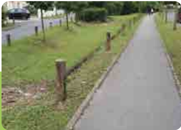
→ La noue d'infiltration
