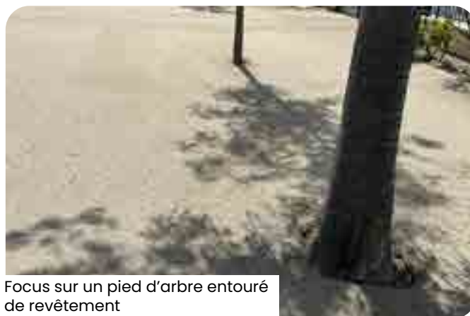
Le revêtement en liant végétal de la cour de l'école maternelle 4 ans après sa pose
