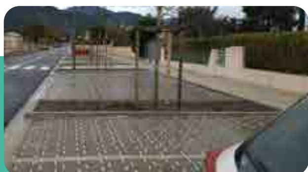
→ Places de stationnement en pavés et graviers
