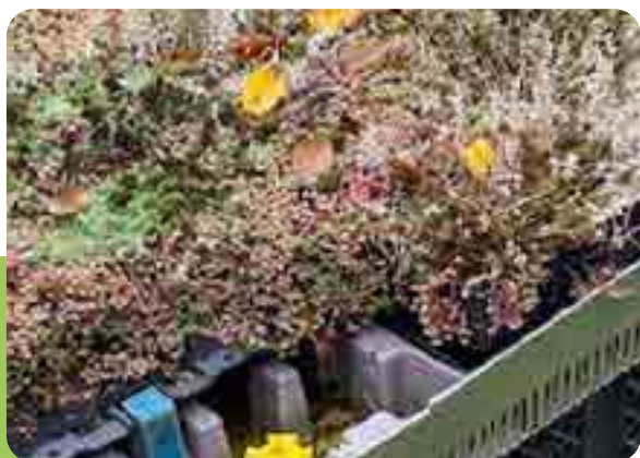
→ La toiture végétalisée
