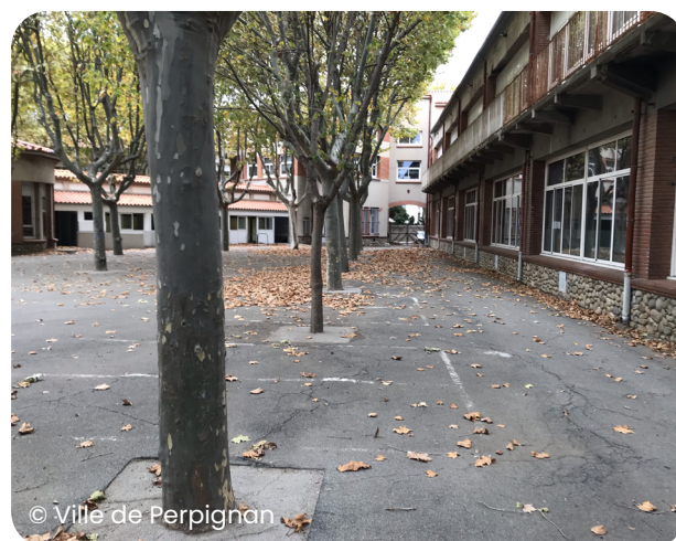
La cour imperméable avant les travaux
