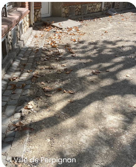
La cour imperméable avant les travaux
