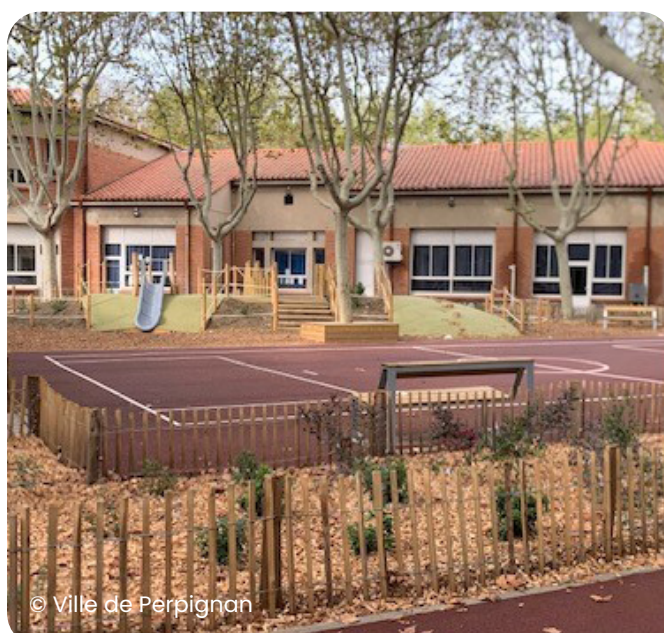
Terrains de jeux en revêtements perméables et sa butte avec jeux variés
