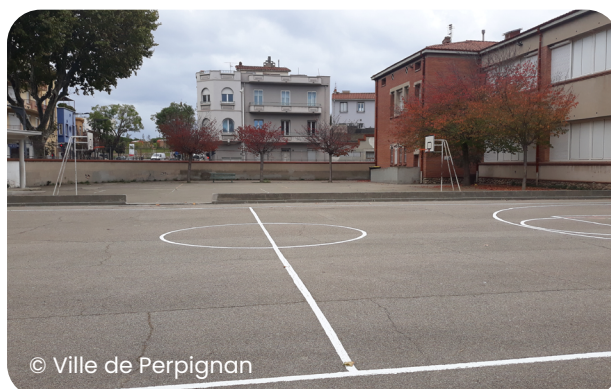
Le plateau sportif en revêtement imperméable
